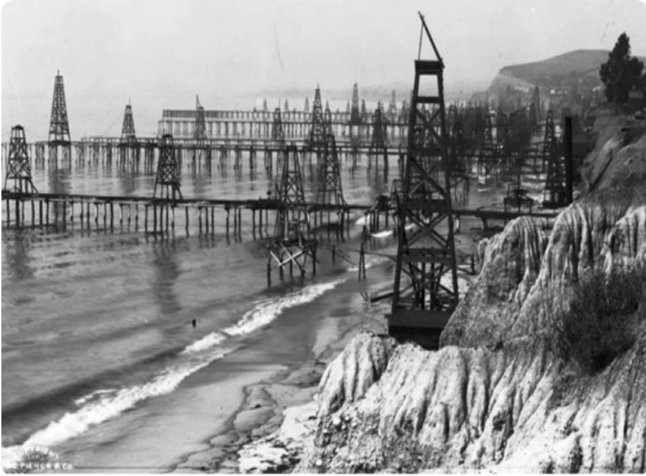
الشكل-10: منصات الحفر الخشبية في كاليفورنيا
